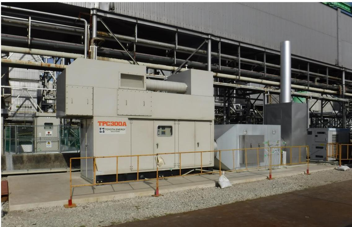
図1． 300kW級マイクロガスタービン
